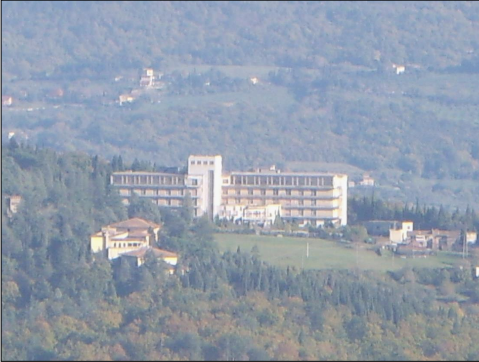
Figura 16. Il Banti visto dal versante ovest.
