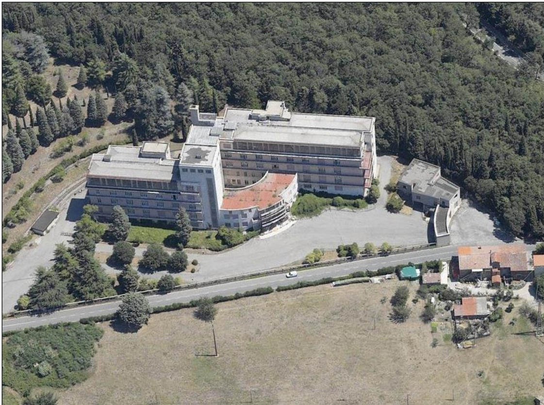
Figura 13. Veduta aerea dell’area (Estratto da bing.com).
