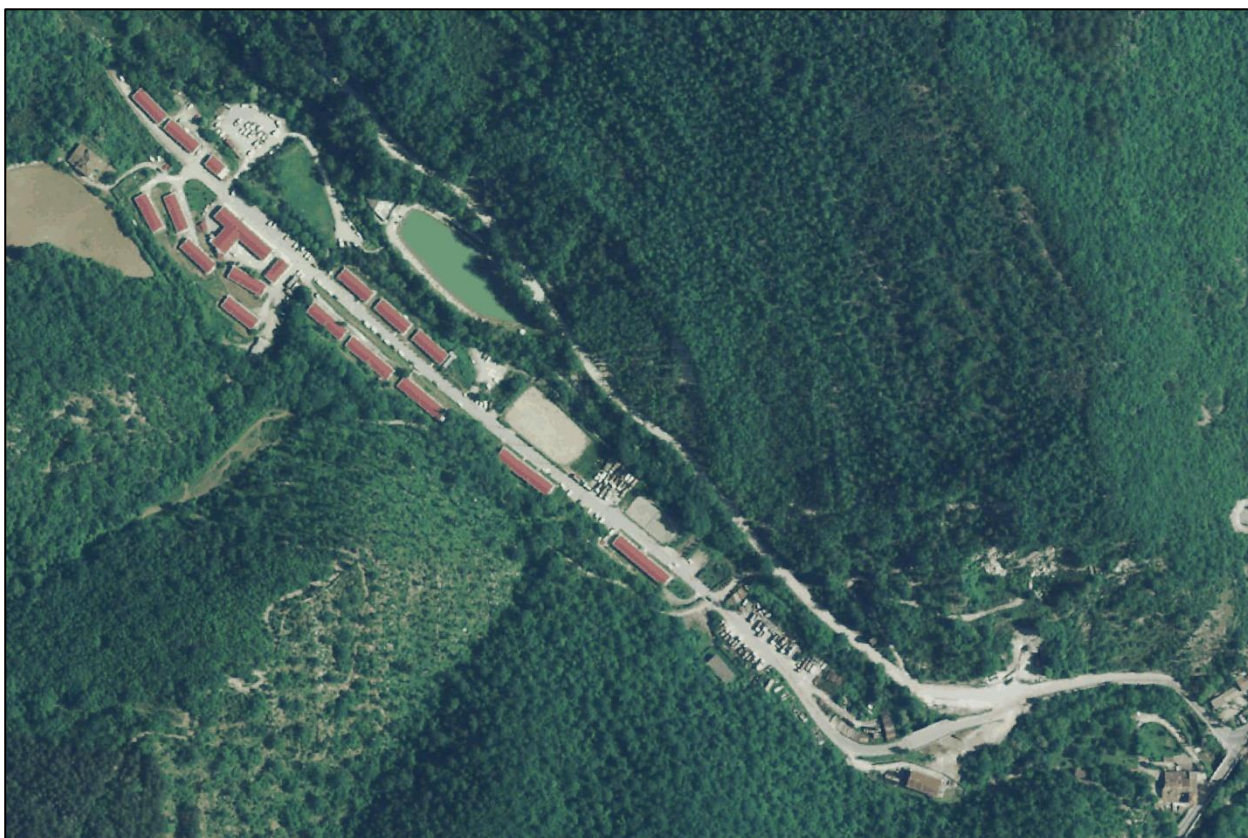
Figura 17. Area dell'Ex cantiere TAV 2007.
