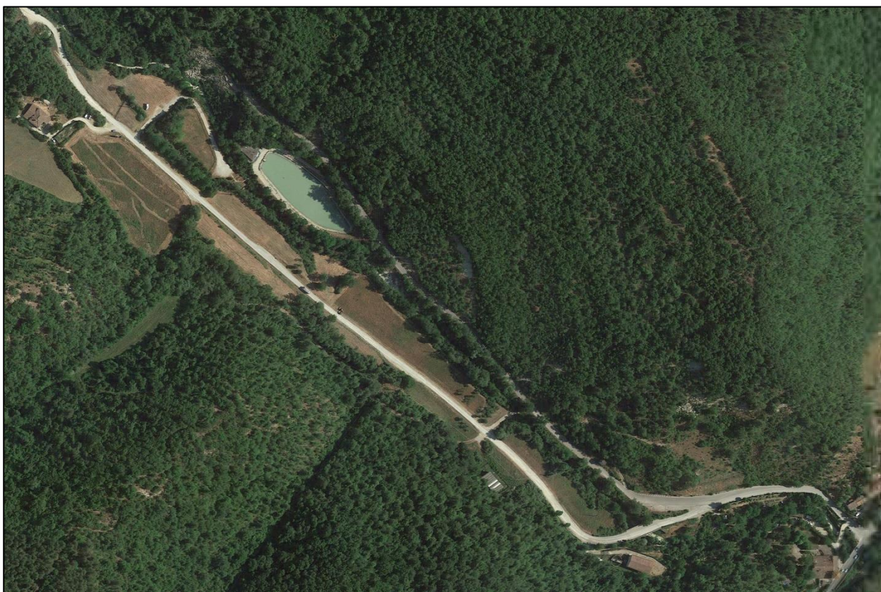
Figura 16. Area dell'Ex cantiere TAV 2018.
