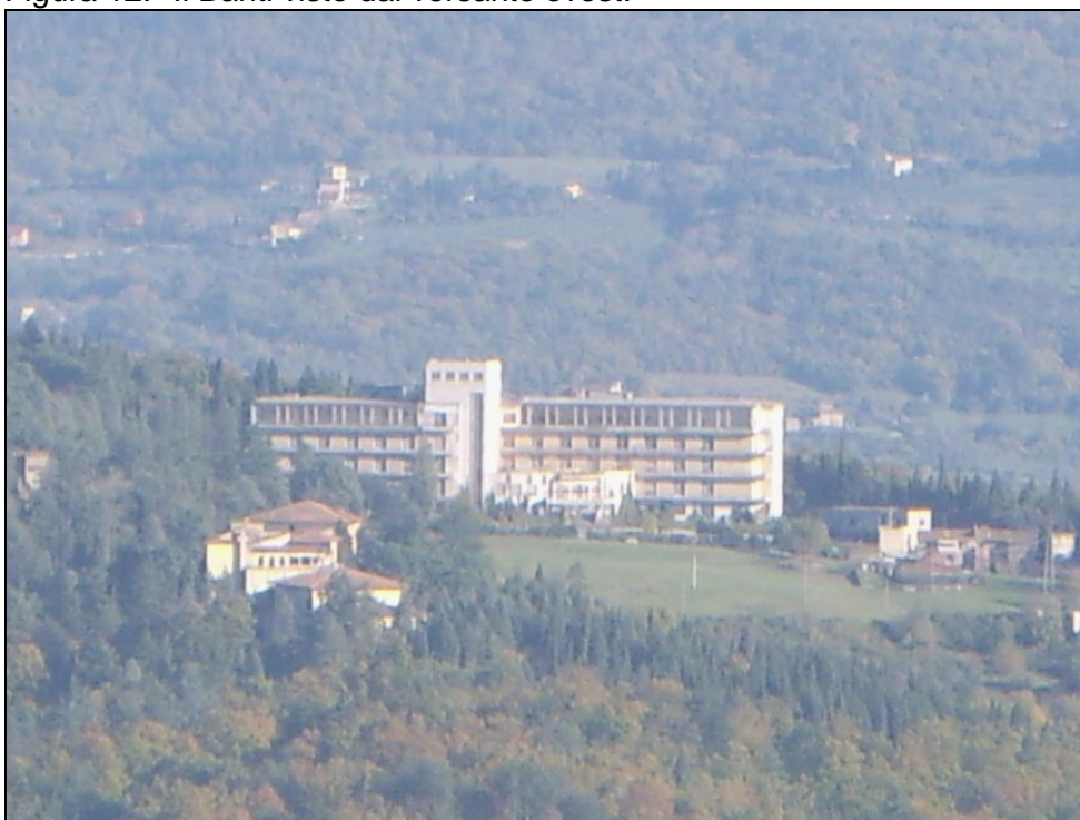
Figura 12. Il Banti visto dal versante ovest.
